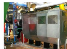
Rund 130 Wohn- und Gewerbehäuser gibt es auf dem Stauferpark-Areal, die Wärmelast beträgt etwa 20 Mio kWh jährlich. Um die Grundlast decken zu können, installierten die Stadtwerke eine ÖKOTHERM®- Biomasse-Heizanlage mit einer Leistung von 600 kW. Rund 500.000 Euro haben die Stadtwerke in das gesamte Projekt investiert. 100.000 Euro davon hat das Land Baden-Württemberg übernommen.
